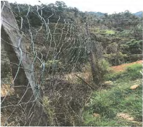
Foto 3: Mejoramiento de la circulacion del establecimiento, con malla galvanizada y tubos galvanizados.
