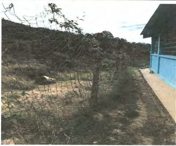
Foto 2: Mejoramiento de la circulacion del establecimiento, con malla galvanizada y tubos galvanizados.
