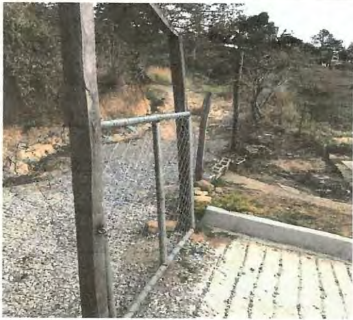
Foto1: Mejoramiento de la circulacion del establecimiento, con malla galvanizada y tubos galvanizados.
